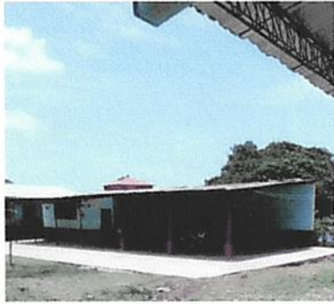
Foto1: finalizacion de 105 M2 de piso de concreto
