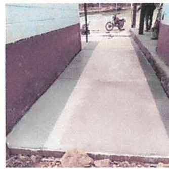
Foto 2: fundicion de piso de concreto en callejón entre salones de clases
