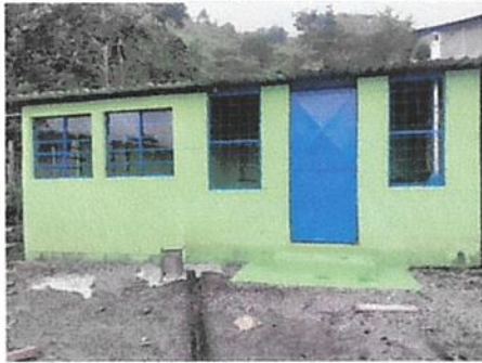
Foto 3: remozamiento de cocina
