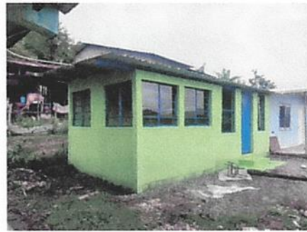
Foto 4: techado nuevo y ventanas de vidrio con metal nuevas
